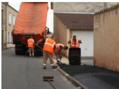
La Grande Rue est le tronçon le plus fréquenté par les piétons pour lesquels les règles d'accessibilité devaient être améliorées. C'est désormais chose faite par une réfection complète sur la partie Sud, avec des bordures franchissables et des bandes podotactiles.
