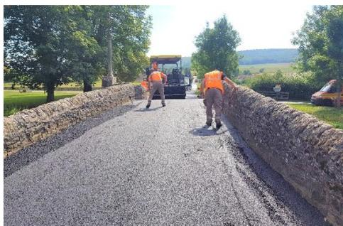
La commune poursuit son plan de rénovation des chaussées abimées par le temps et l'usage. Ainsi la rue du cimetière a été remise en état, avec le remplacement de l'enrobé sur la partie basse et par le dépôt d'une émulsion gravillonnée sur la partie haute. Les accotements ont été stabilisés pour un meilleur cheminement pédestre.
