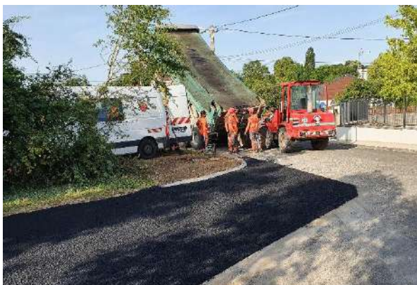
Réfection des bordures et trottoirs lotissement de Confle.
