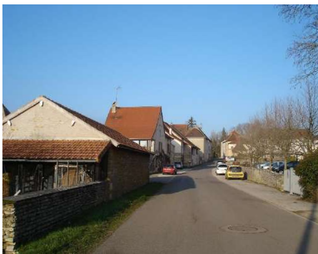
Enfouissement des réseaux rue de l'Hôpital (programme établi avec le SYDESL lors d'une étude effectuée en 2019)
