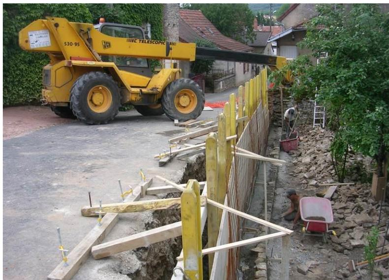
réglementation précise que la charge de l'entretien revient au propriétaire du terrain surplombant, responsable de la poussée. La municipalité a obtenu une subvention concernant les infrastructures et a fait refaire un mur en béton armé orné d'un parement de pierres qui stabilise toute la chaussée et écarte tout risque de déformation ultérieure. Ce très beau travail a été conduit par l'entreprise Pereira.
