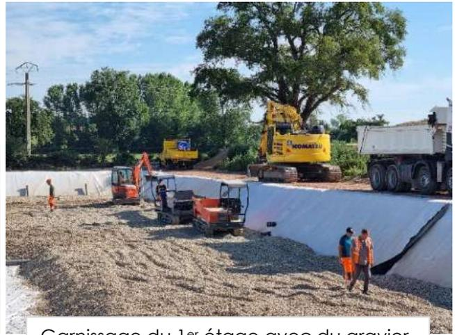
Garnissage du 1<sup>er</sup> étage avec du gravier
