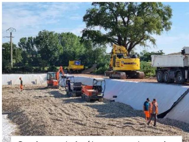
Garnissage du 1<sup>er</sup> étage avec du gravier
